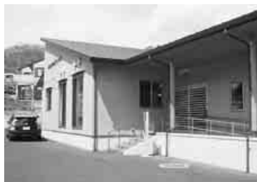
敷地は700坪。日当たりもよく駐車場も広い
