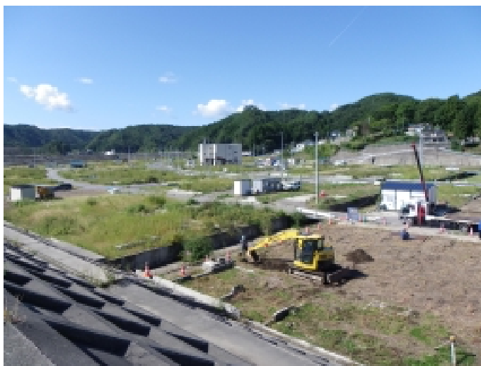
巨大堤防を津波は軽々越えていった（岩手県）
